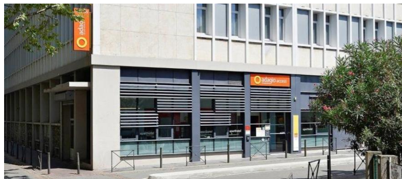
ADAGIO BOULOGNE BILL. – 2024 - Installation d'un office de cuisine pour petits déjeuners
