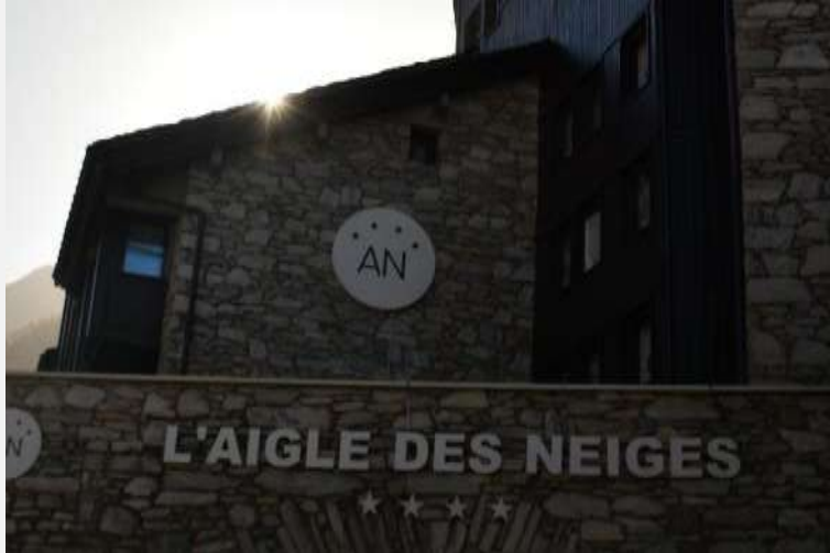
Hôtel L'Aigle des Neiges. Val d'Isère Désamiantage
