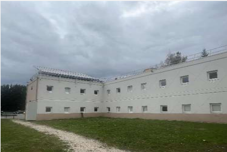
F1 Fernay Voltaire Ravalement façades
