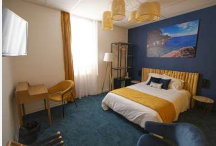
Hôtel Atlantis Cannes 3* Rénovation chambres
