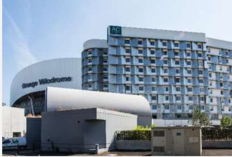
Hôtel Mariott Marseille Isolation Thermique par l'Extérieur
