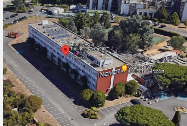
Novotel Toulouse Purpan Aéroport Climatisation
