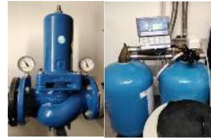
Ibis budget Erding H8697 - Austausch Enthärtungsanlage und Druckminderer
