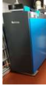
Ibis budget Putzbrunn H2637 - Austausch Heizungsanlage 300 kW,
