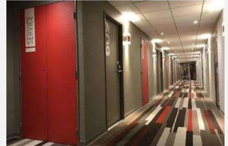
Photo 3 Rénovation chambres et circulations
