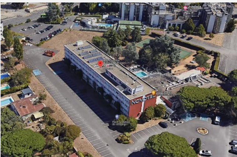
Novotel Toulouse Purpan Aéroport Travaux entretien électrique
