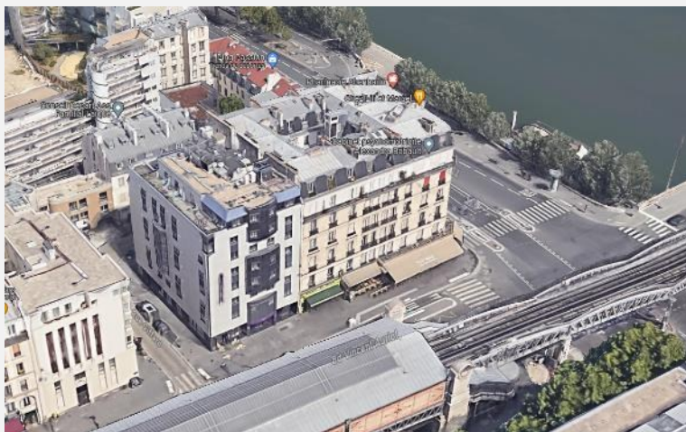
Mercure Hotel Paris Bercy Bibliotheque Travaux de climatisation
