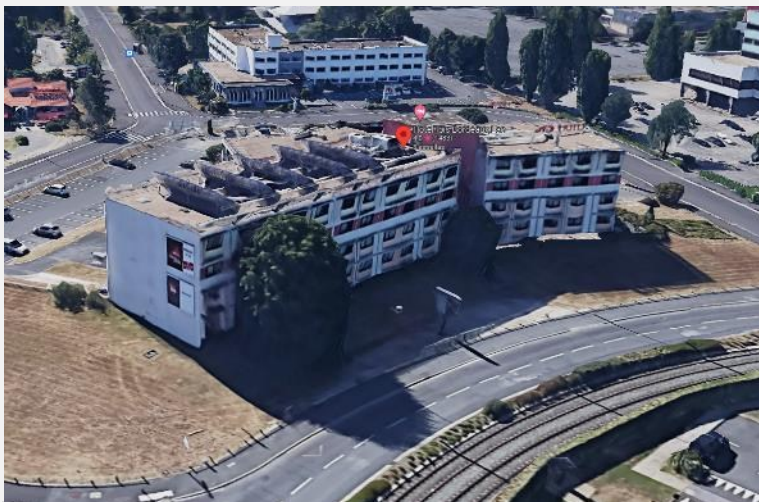
Ibis Bordeaux Le Lac Travaux entretien électrique
