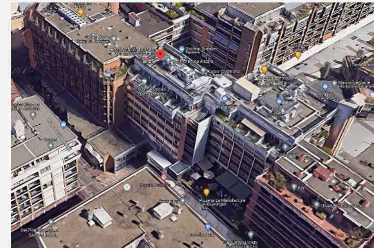
Mercure Toulouse Saint Georges Travaux entretien électrique
