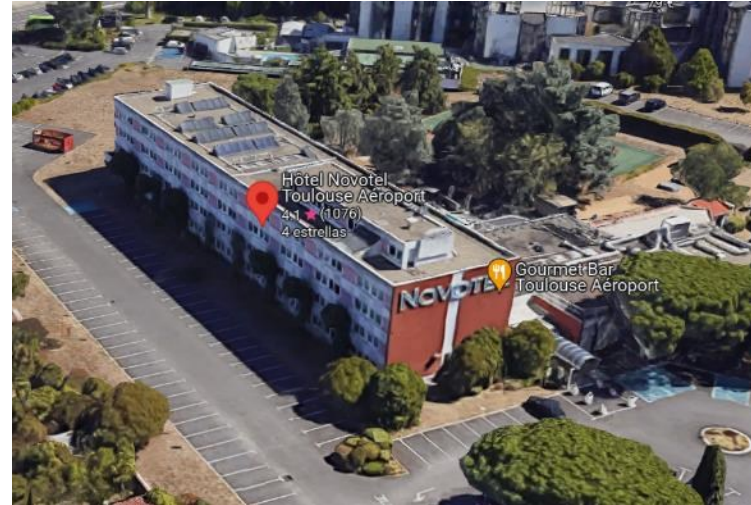
Novotel Toulouse Purpan Aéroport Climatisation
