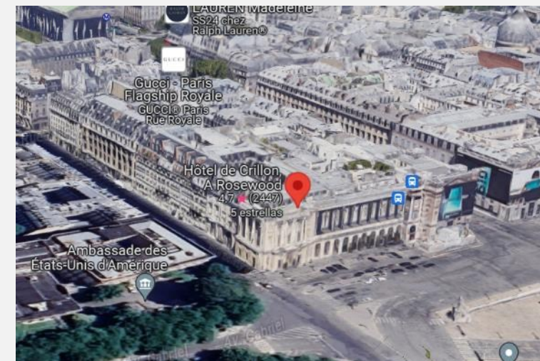
SMH Hôtel De Crillon Climatisation
