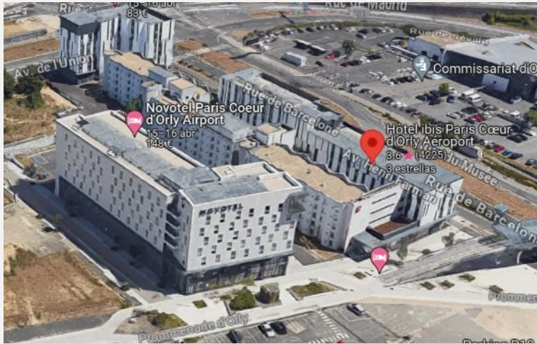
Ibis Orly Aéroport Plomberie et chauffage
