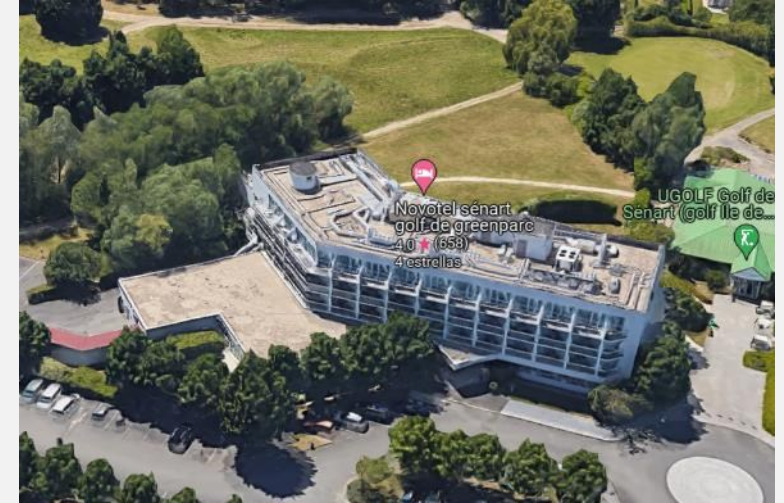
Novotel Senart Golf de Greenparc Rénovation installation plomberie
