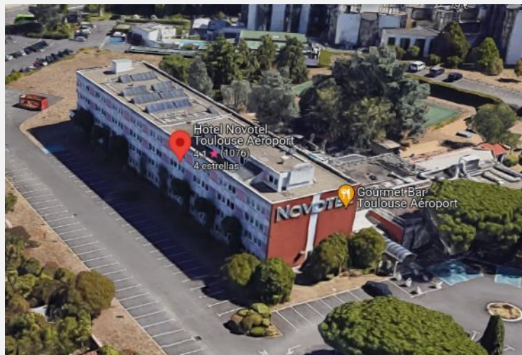
Novotel Toulouse Purpan Aéroport Climatisation
